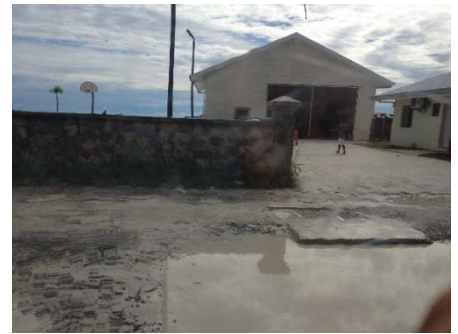
1 舗装されていない道路
